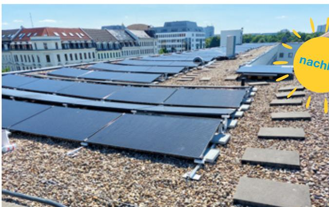
Die Anlage hat eine Leistung von 80 kW. Wenn also an einem Tag 6 Stunden lang die Sonne scheint, kann die Anlage 480 kWh Strom erzeugen. Zum Vergleich: Wenn in der Arbeitsgruppe Metall alle Maschinen laufen, werden 120 kW Strom benötigt. Und auch Tischlerei, Wäscherei oder Küche brauchen viel Strom. Die Diakonie am Thonberg verbraucht am Standort Eichlerstraße 2 jährlich 368.208 kWh Strom.
